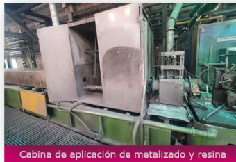
Cabina de aplicación de metalizado y resina
