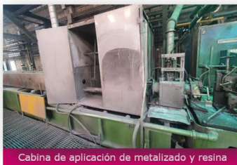
Cabina de aplicación de metalizado y resina
