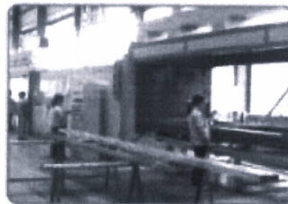
TRANSFERENCIA DE MADERA
